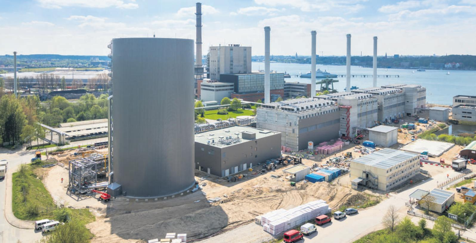
**Zu einer richtig grossen WKK-Anlage gehört auch ein grosser Wärmespeicher: Neubau Gasmotoren-Kraftwerk der Stadtwerke Kiel, Norddeutschland ([www.stadtwerke-kiel.de](http://www.stadtwerke-kiel.de)): 190.4 MW<sub>el</sub> Nettoleistung, 192 MW<sub>th</sub> Wärmeleistung. Der Wasser-Wärmespeicher beeindruckt: Ø 31.2 m, 60 m hoch, 30 000 m<sup>3</sup> nutzbar, Kapazität über 1500 MWh bei Betrieb im Bereich 60-115°C. (Referat Klaus Payrhuber, GE Jenbacher GmbH)**
